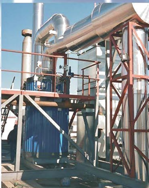
RECUPERACIÓN DE CALOR EN COGENERACIÓN
